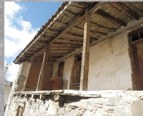
Κατασκευή οροφής. Βολίτζια που κατασκεύαζαν από κορμούς δέντρων, καλάμια κλαριά δέντρων, χώμα και χωλετρωτά κεραμίδια.
