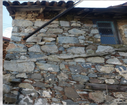
Τοπική σιδηρόπετρα με χαλίκωμα από άλλους μικρούς οπτόπλινθους χωρίς επίχρισμα.
