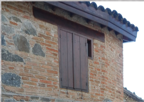
Οπτοπλινθοι απο γειτονοκα χωρια. Χρήση επιχρίσματος μόνο στους αρμούς.
